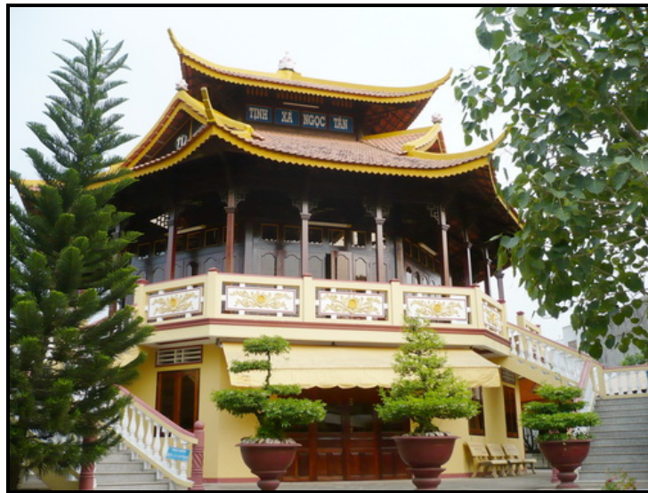
Tịnh xá Ngọc Tân ở thành phố Tân An Ngôi chánh điện này do chú Thiện Ngộ thiết kế và thầu xây dựng.
